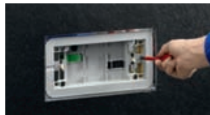
4 Pagrindo plokštė pritvirtinama ant nuplovimo bakelio, tada sumontuojamas nuspaudimo mygtukas.
