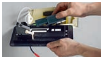
2 Korpusas su servo varikliu uždedamas ant sumontavimo rėmo ir sumontuojamas rankinis įjungiklis, reikalingas nuplovimui įjungti gedimo atveju.
