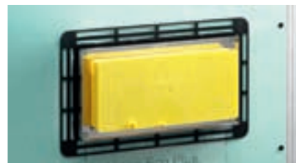
2 Ištiesintas sumontavimo rėmas užklijuojamas ant gipso kartono plokštės.
