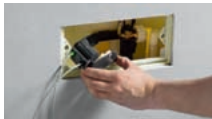
1 Mechanika pakeičiama troselinio valdymo mechanizmu su servo varikliu.
