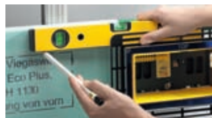
1 Ant apdailos plokštės pažymimas sumontavimo rėmas ir joje pjūkleliu išpjaunama rėmo formą atitinkanti skylė.
